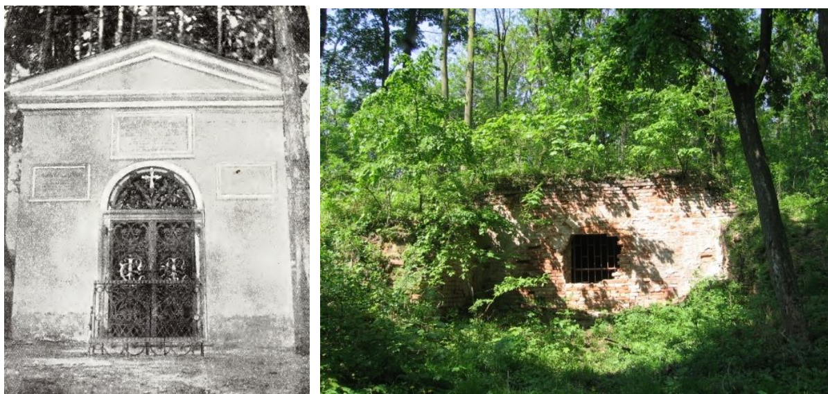
Původní a současný stav kaple sv. Andělů strážných
